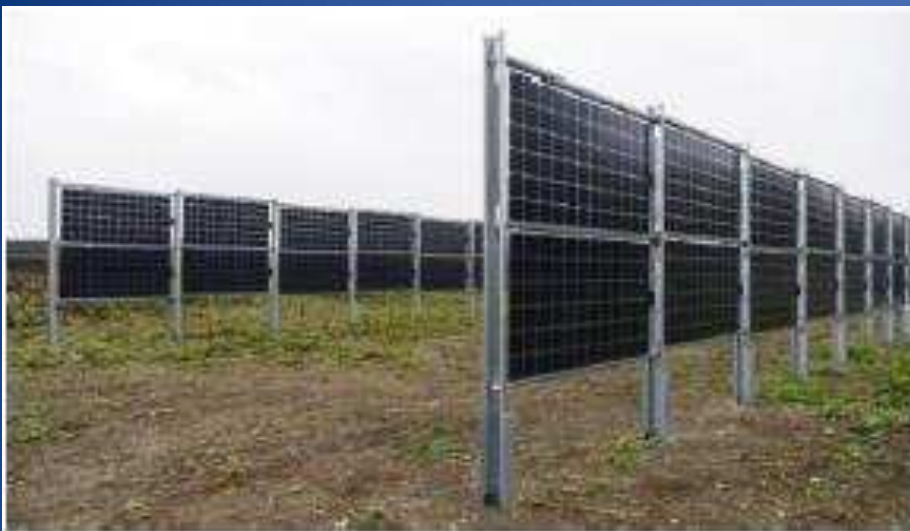
Pannelli PV (Photovoltaic) fissi verticali bifacciali inseguimento
