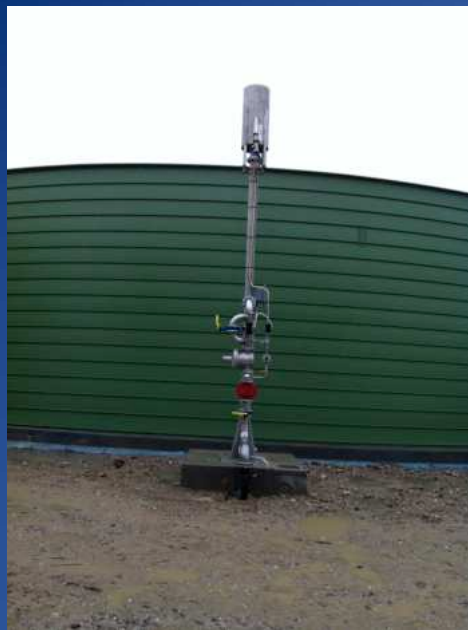
Torcia di emergenza (brucia il biogas in eccesso)
